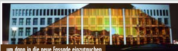
...um dann in die neue Fassade einzutauchen
