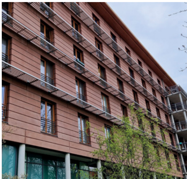
Haus Gürtelstraße 32 vor dem Anstrich...
