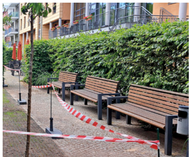
Baumaßnahmen auf der ehemaligen Kaninchengehege-Fläche
